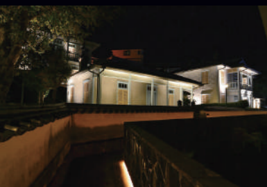
東山手洋風住宅群 (F棟)
