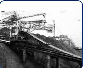
精炭（精選された石炭）は、このベルトコンベアによって貯炭場に蓄えられ、石炭運搬船に積み込まれました。今はその支柱が残るのみです。
