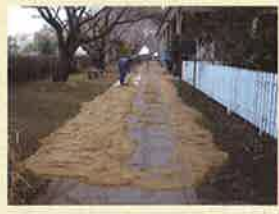
アスファルトの道路に砂を撒きました
